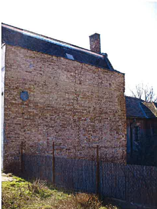
Repedés a nagyterem hátsó homlokzati falán az alapozástól kezdődően az eresztővonalig, közel függőleges irányban. Attika fal mögött húzódik a fekvő, vagy rejtett ereszcsonna.
