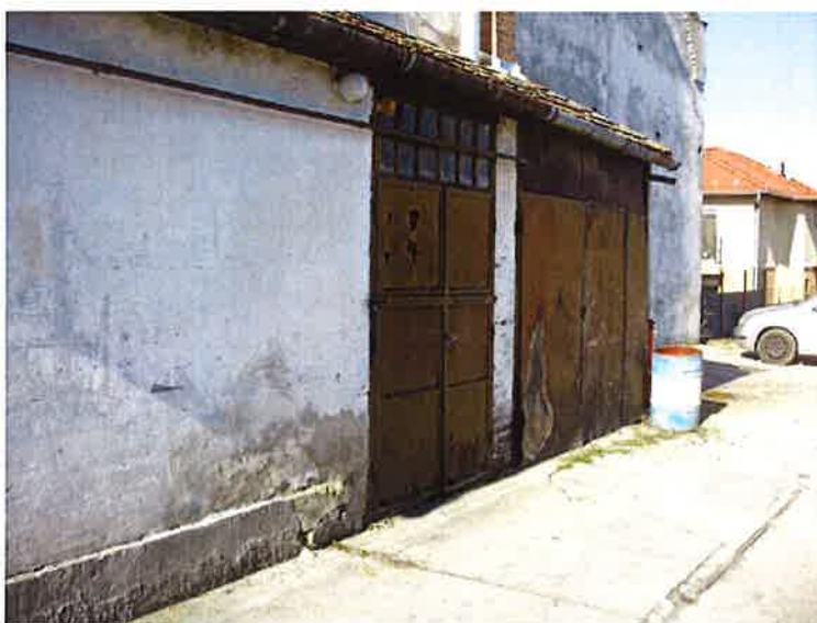
Felázott lábazati szakasz a szabálytalan helyen álló épületrészen.
