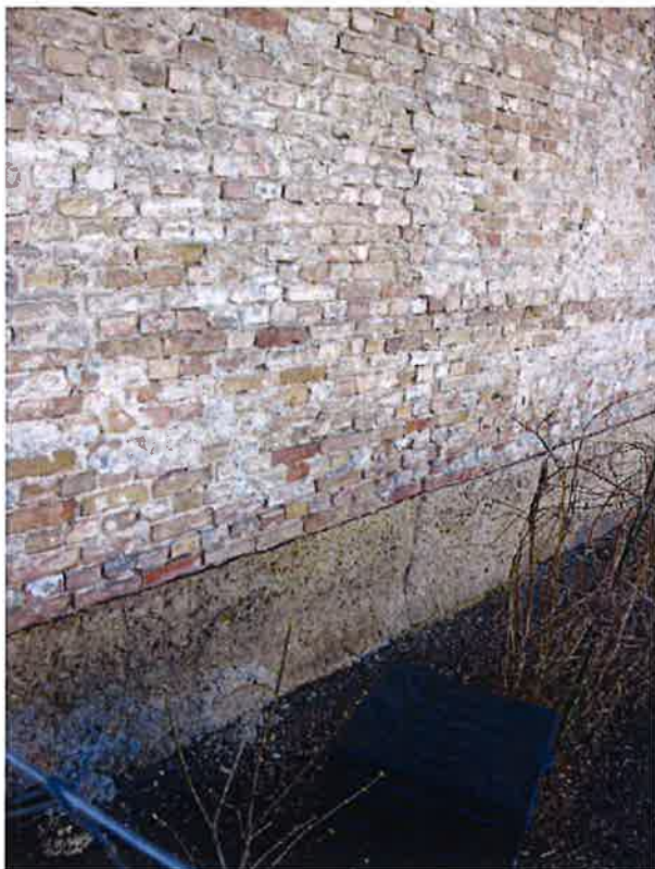
Repedés a nagyterem hátsó homlokzati falán az alapozástól kezdődően az eresztővonalig, közel függőleges irányban. Attika fal mögött húzódik a fekvő, vagy rejtett ereszcsonna.
